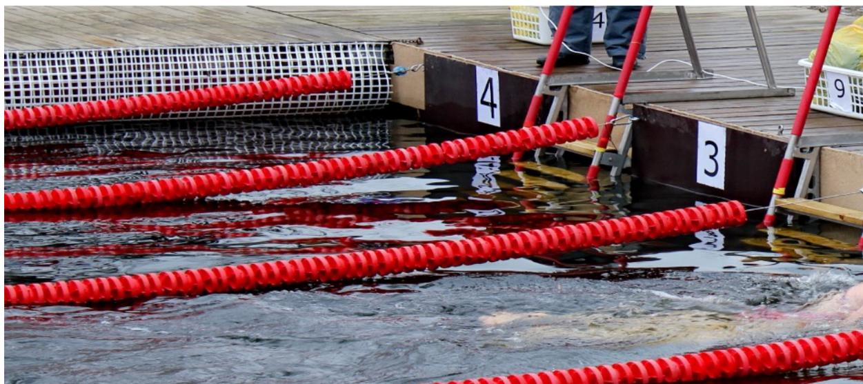
Рисунок 4 - Крепление разделительных дорожек к торцевым стенкам
